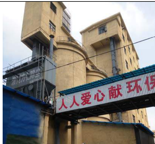
中碎车间及布袋除尘器
